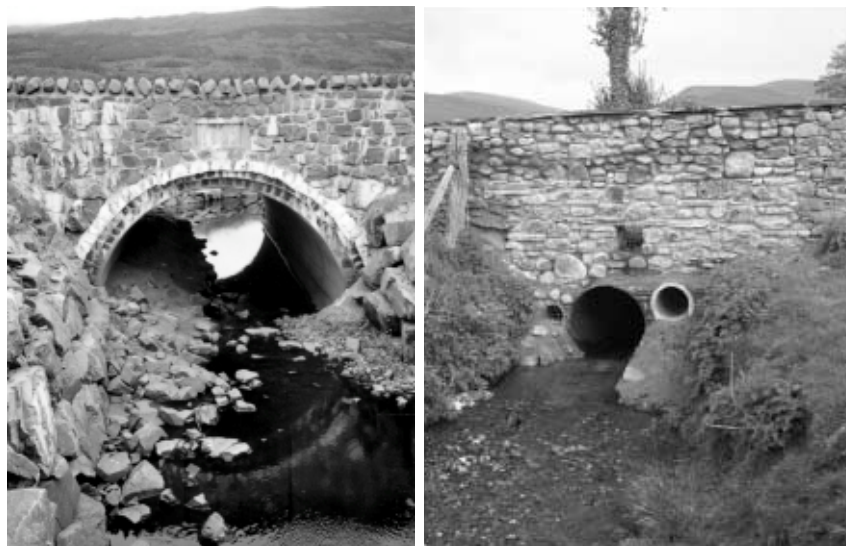
Mesure compensatoire pour la loutre en Ecosse (Ile de Skye) ou au Pays de Galles : berge artificielle bétonnée sous ouvrage, ou buse hors d'eau. (photos L. Lafontaine & G. Liles).
