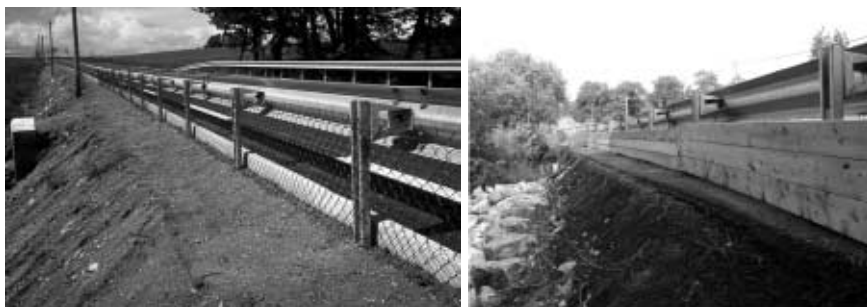
Deux exemples français de dispositifs destinés à interdire aux loutres l'accès à la chaussée : engrillagements bas (RD 8, Côtes d'Armor) ou palissades en bois (RD 773, Loire Atlantique), fixés en arrière des glissières de sécurité. (photos L. Lafontaine et PNR de Brière).
