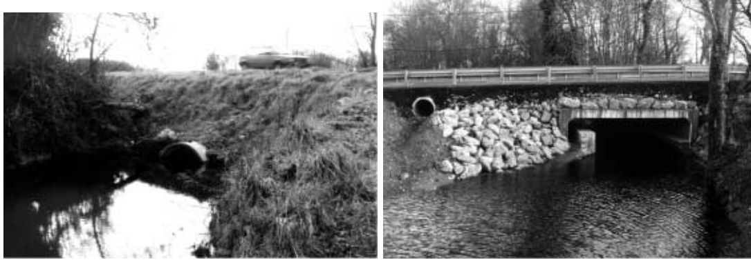
Le pont de la Duchée avant et après travaux (Photo Parc naturel régional de Brière).
