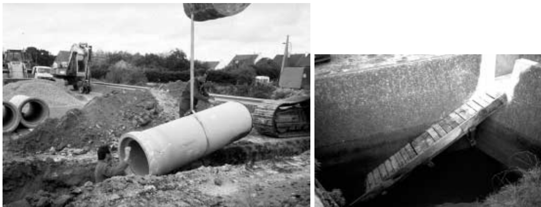
Sur la route de la Presqu'île de Rhuys (Morbihan), l'aménagement a posteriori d'un passage busé sous la route départementale et d'une banquette inclinée en bois pour passer le barrage de l'étang en amont, a coûté en 1992 l'équivalent de 30.000 de travaux au Conseil Général du Morbihan. (Photos L. Lafontaine).
